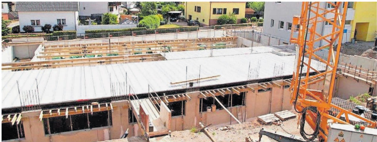
So sieht der Anbau der Gemeinschaftsschule Freisen momentan aus.
