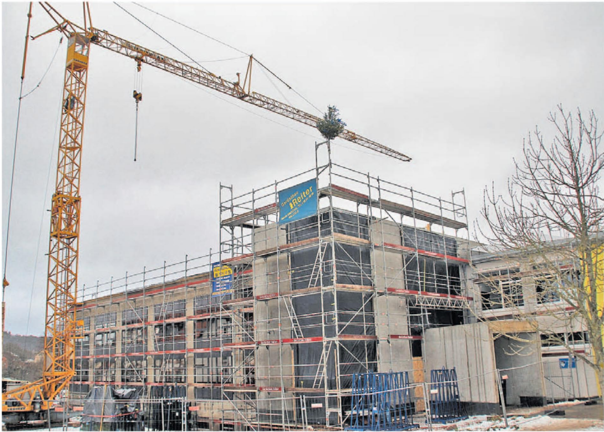
Der Richtstrauß weht auf dem Erweiterungsbau an der Freisener Gemeinschaftsschule. Beim Richtfest war jedoch niemand auf dem Dach. Dafür war das Wetter zu schlecht. Zu Beginn des Schuljahres 2018/19 soll das Gebäude mit einer Bruttofläche von 660 Quadratmetern fertig sein.
